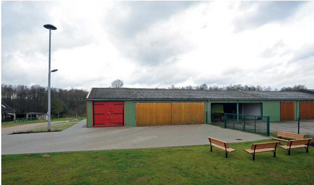
Feuerwehrhaus in Borkow
