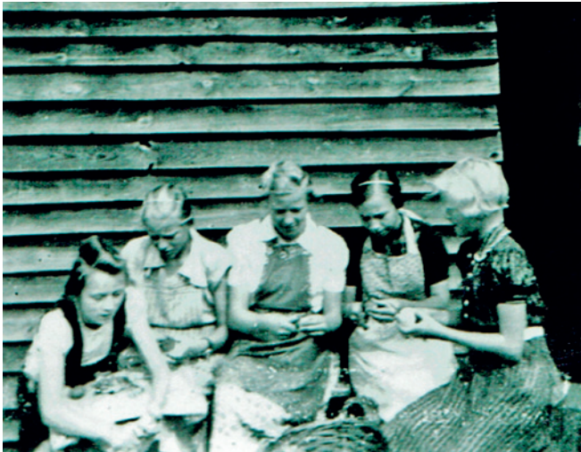
Sommer 1955: Auf der eingezäunten, aber un bebauten Fläche neben der heutigen Bushaltestelle stand das Holzhaus der Familie Mahler aus Berlin. Dieses Gebäude wurde von der Grundschule Borkow in den 50er Jahren als Ferienspielheim genutzt. Das Foto zeigt die immer fleißigen Mädchen beim Kartoffelschälen: von links nach rechts: Ingrid Göhlert, Lisa Rogmann, Hiltrud Obert, Herta Hermann, Annelies Höcker. Die Jungen durften toben und Baden!!!
