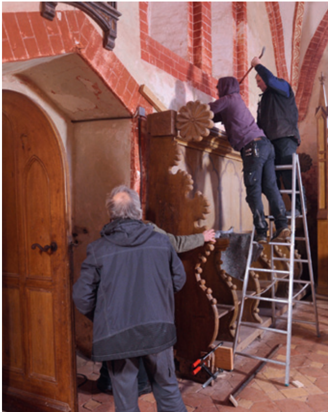
Das Chorgestühl wird von der Wand gerückt.
