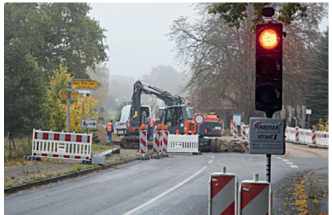
Rückbau des Bahnübergangs Oktober 2016
