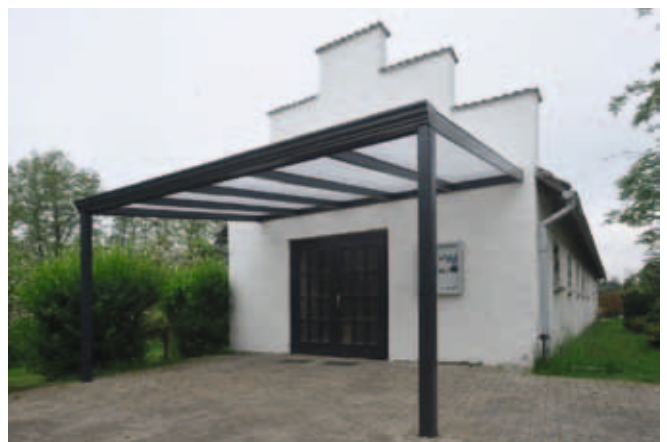
Die Trauerhalle mit neuem Vordach
